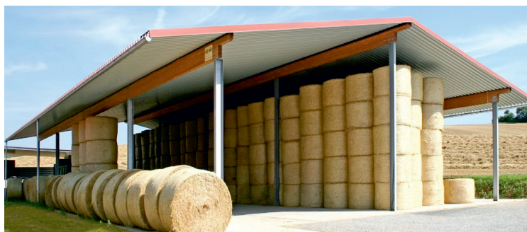
Рис. 2. Примеры использования в конструкции хранилищ элементов из клееного бруса
